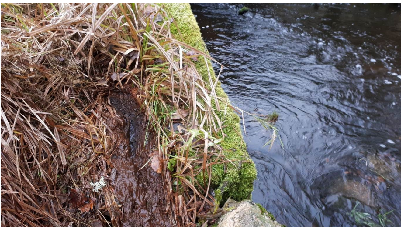
Foto 6 (15.11.2021). Truubi väljavoolu parempoolse külgmüüri ja pinnase vahelt oli märgata filtratsiooni.
